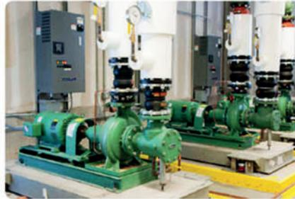
**Figura 1: Las bombas de control variable son 30% más eficientes que las de control fijo.**
